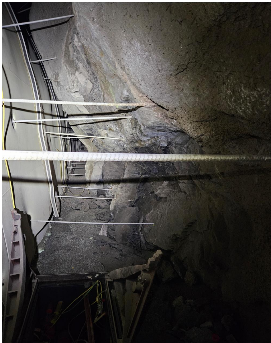
Foto 4: Nedfall av stein i nedre del av vegg på venstre side ved profil 5035.
